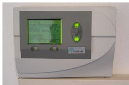
Klein aber oho – die zentrale Einheit steuert das gesamte Heizsystem.
